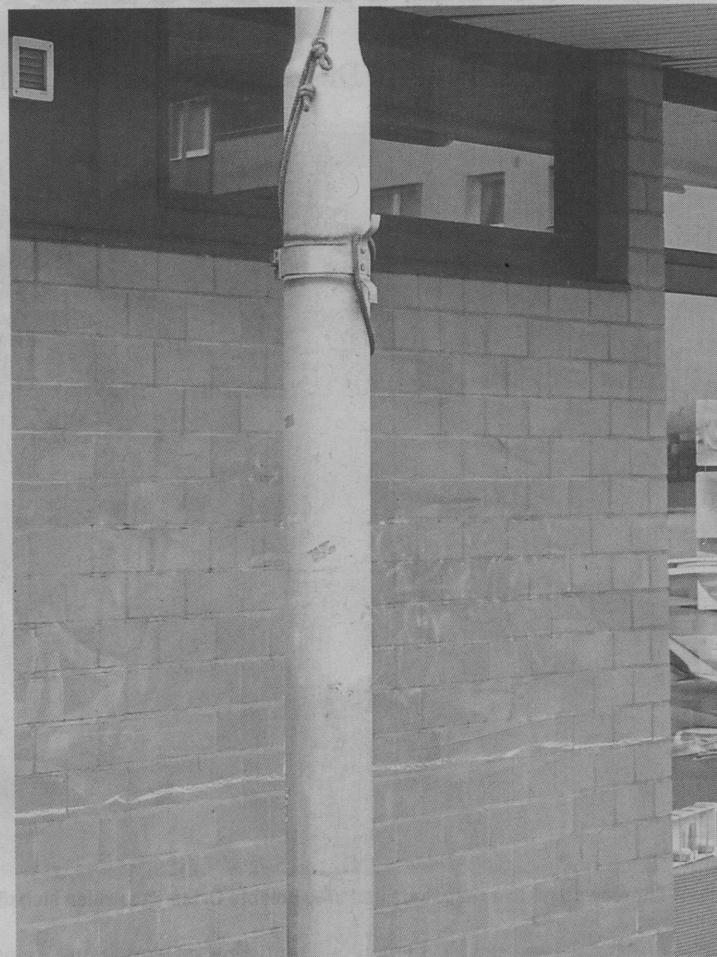
Der Gebäudekomplex in der Eberstädter Straße in Nieder-Ramstadt soll abgerissen werden.
